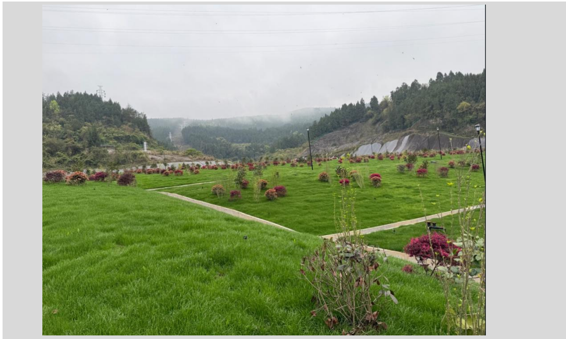
图 2-1 武隆区城市生活垃圾填埋场封场项目现状
