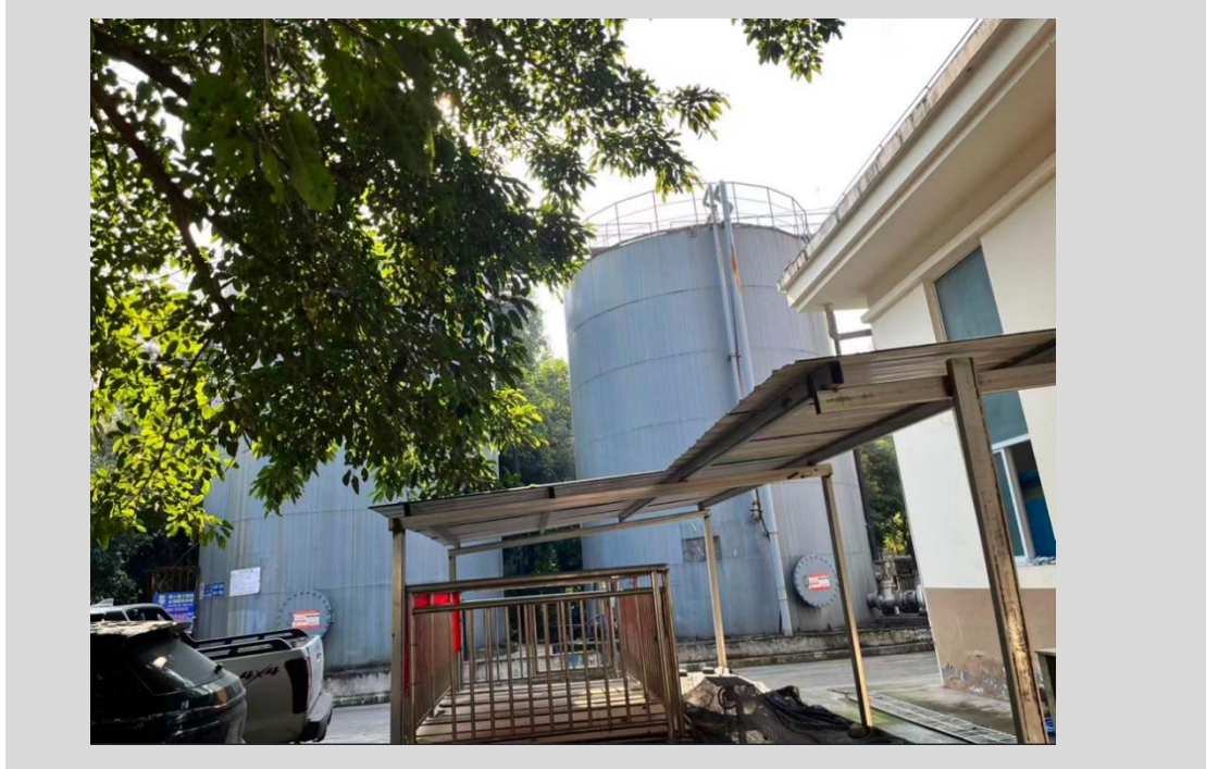
图 2-2 武隆城市生活垃圾填埋场渗滤液处理现状
